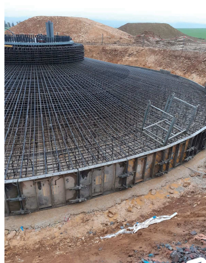
Tas séparés de terre végétale et de terre excavée pour la fondation (réemploi)
