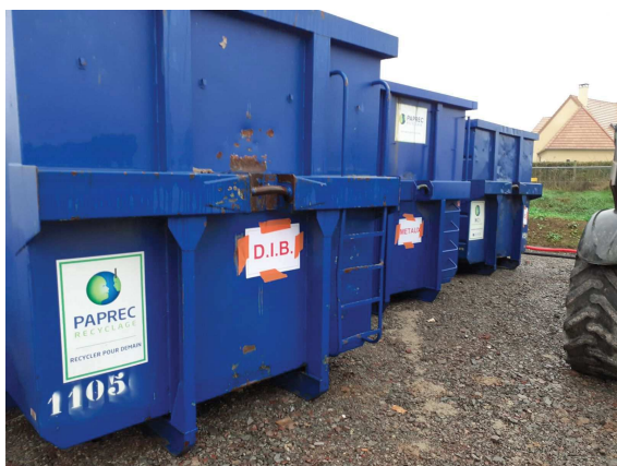
tri des déchets de chantier sur la base de vie
