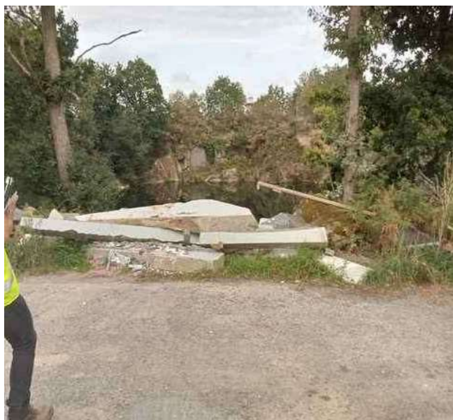
photo de l'inspection du 26 septembre 2023
