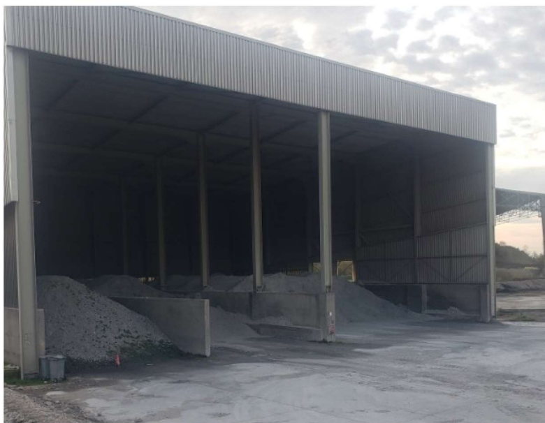
Photo 2 : Hangar de stockage des matériaux non inertes pollués.
