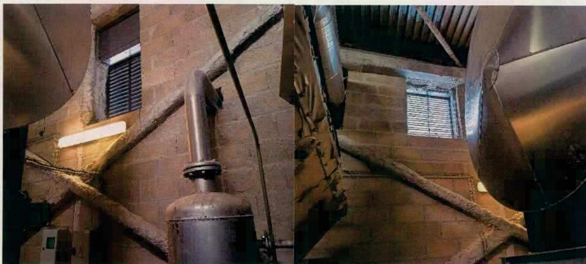
Figure 4 et 5 : trappes de désenfumage
