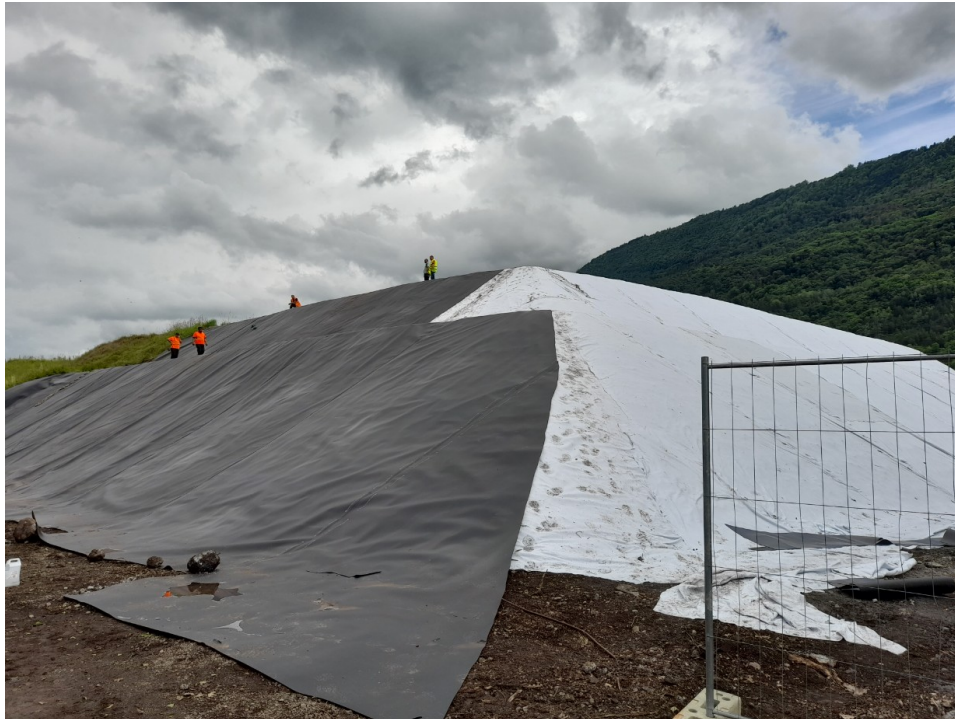
Vue des flancs ouest et sud des cellules 2bis et 3bis
