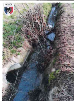
sortie bassin d'orage
