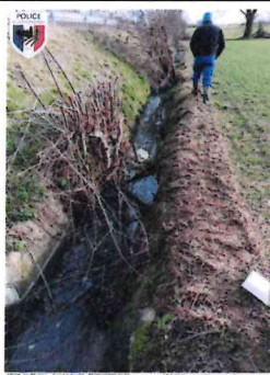
sortie bassin d'orage parcelle exploitant
