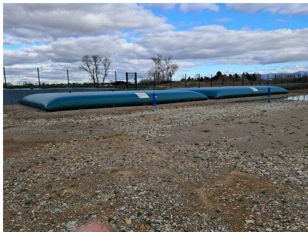
Photo des deux réserves d'eau au Nord du site
