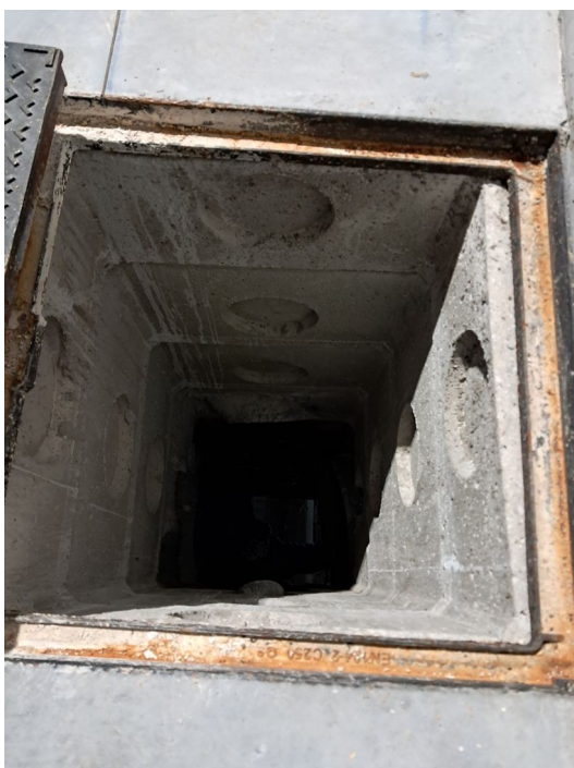
Regard d'eaux pluviales dans la cellule 1, côté Sud
