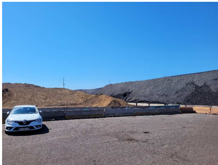
Stockage de biomasse (à gauche) et charbon (à droite)
