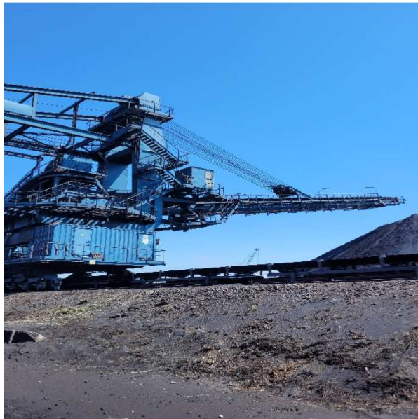
Stacker pour la mise en stock du charbon
