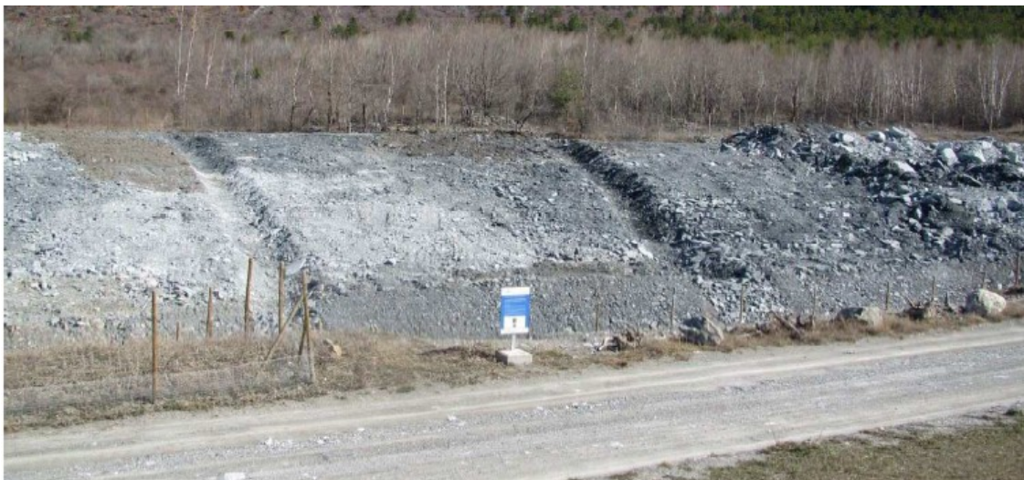
Secteur des fossés de recoupement des Eaux pluviale (le 18/03/2016)
