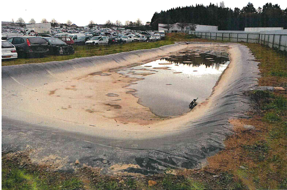
Bassin étanche permettant le confinement des eaux d'extinction de la zone d'entreposage des VHU non dépollués
