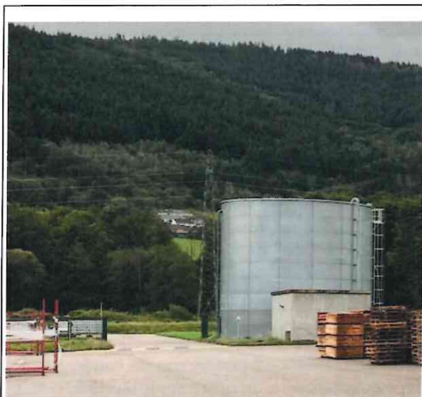
Figure 4: nouvelle cuve de sprinklage
