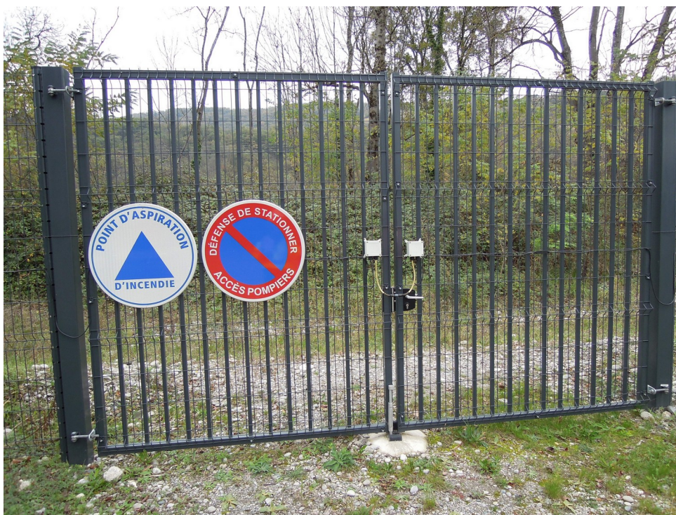
Portail d'accès à l'aire d'aspiration non aménagée
