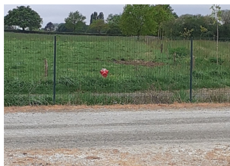
Poteau incendie devant le site
