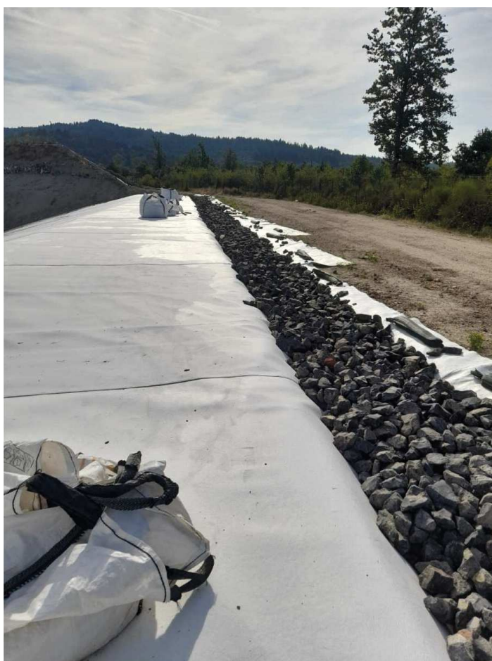
Ancrage et fossé de collecte talus Sud
