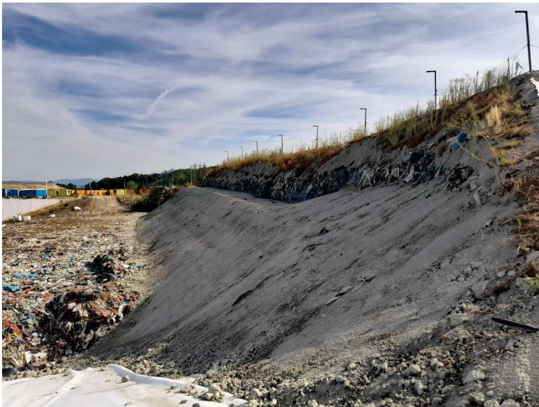
Confortement talus Est casier 3.3
