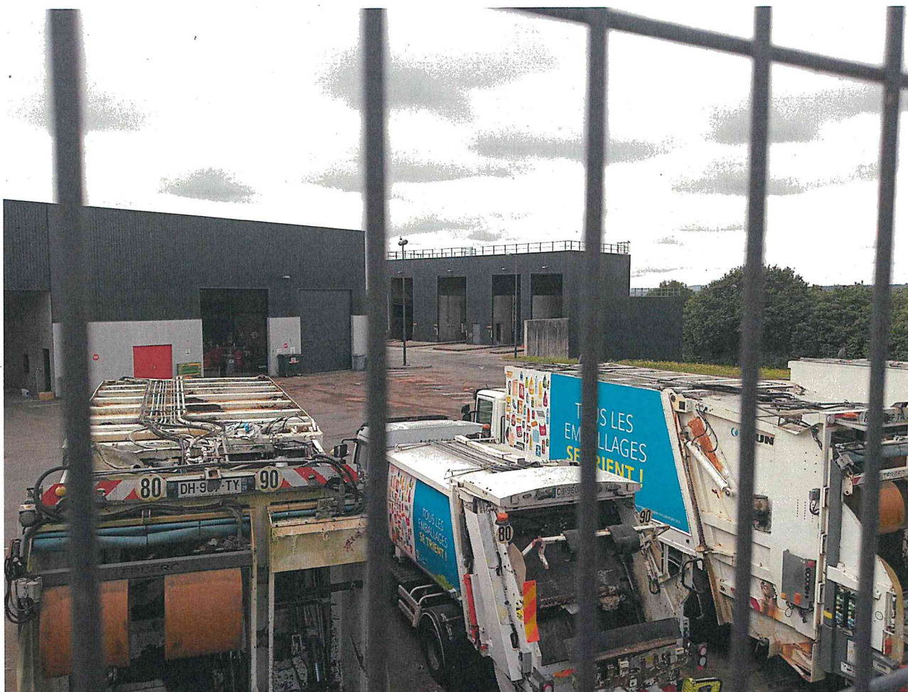
Aperçu au second plan des portes hautes de la tour de transfert, en position ouverte. Au premier plan, bennes de collecte stationnées.
