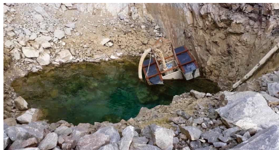
pompage fond de fosse
