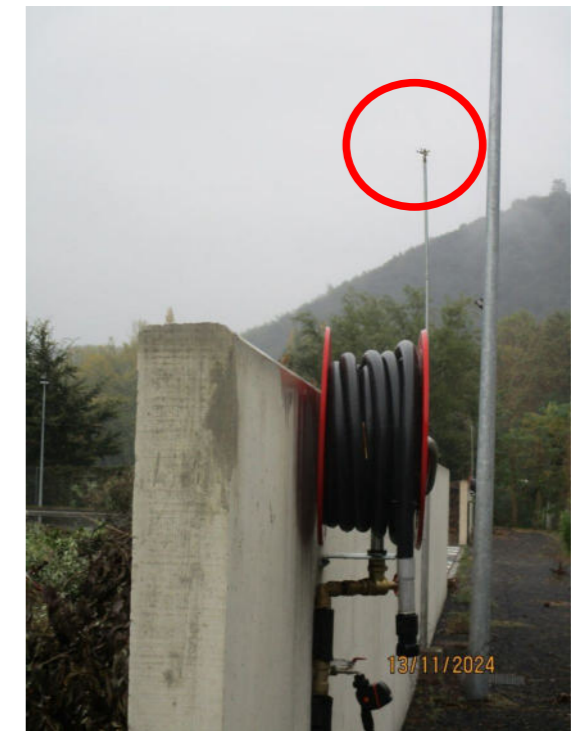
1 autre des 4 RIA et un autre des 3 asperseurs (entouré en rouge)
