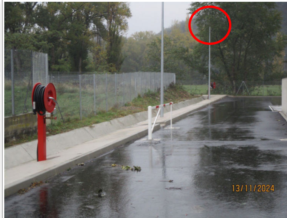
2 des 4 RIA et un des 3 asperseurs (entouré en rouge)
