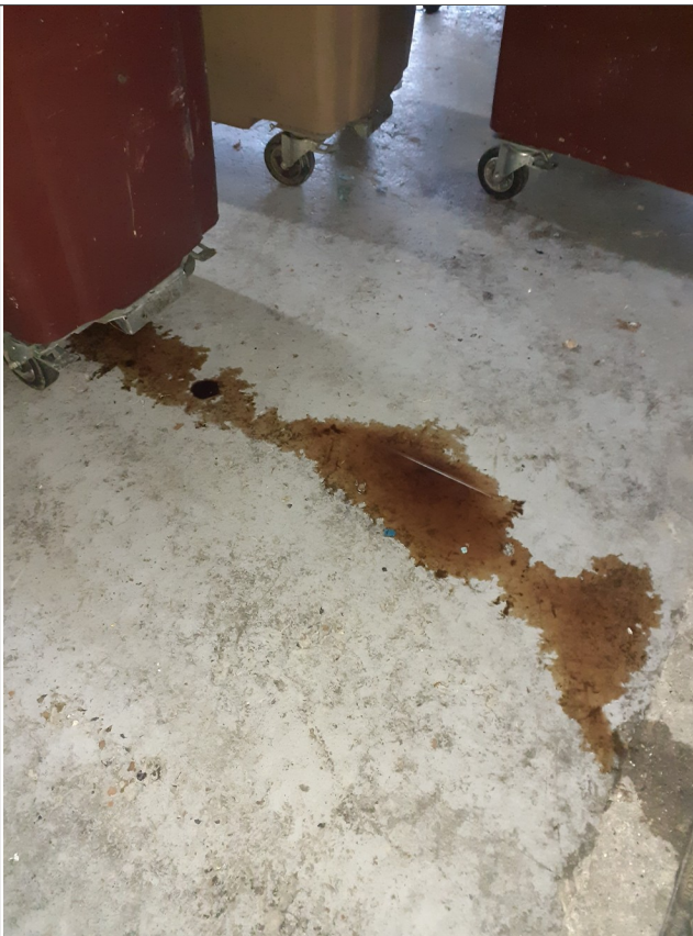
Écoulements issus des bennes de broyats
