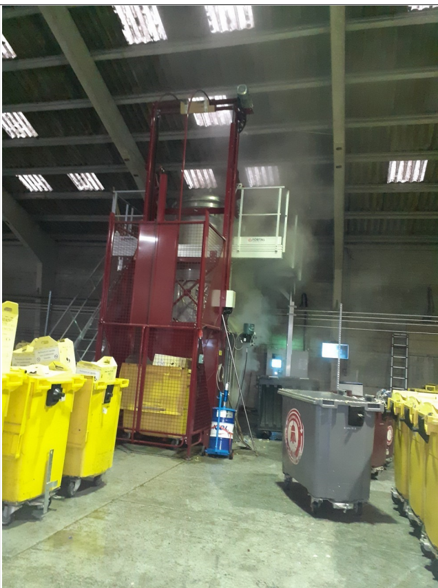
Vapeur odorante sortant de l'unité de désinfection
