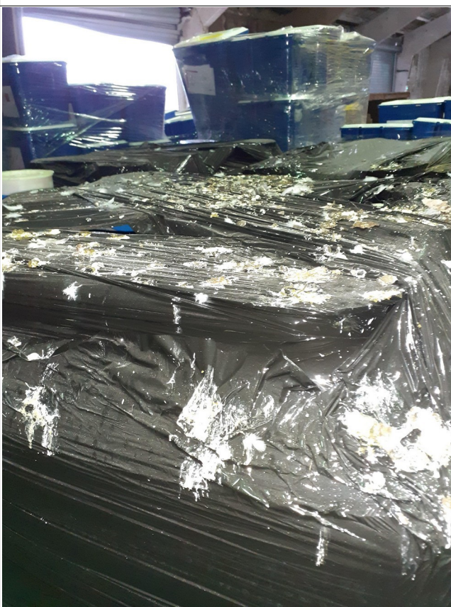
Déchets souillés par des excréments d'oiseaux au sein du bâtiment
