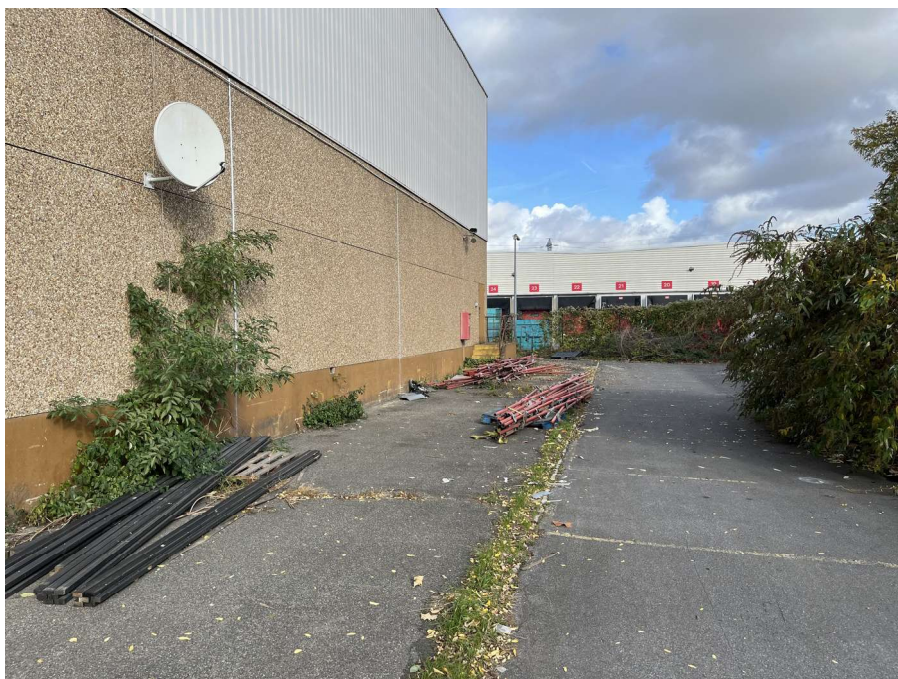
Annexe 6: Voie engins obstruée, empêchant aux secours de manœuvrer
