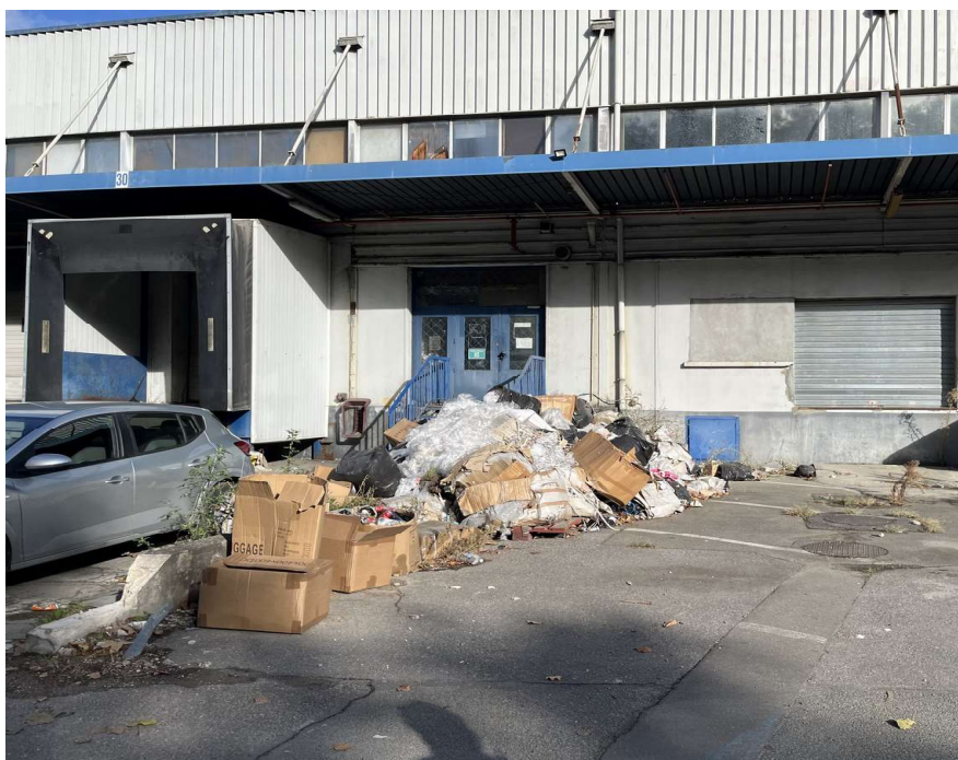
Annexe 9: Déchets et résidus de plastiques et cartons jonchant le parking du site
