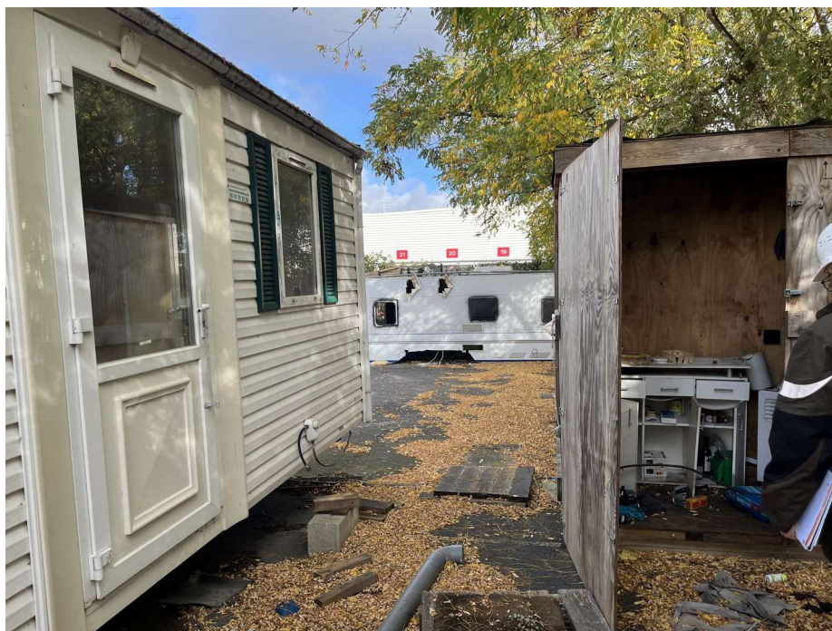
Annexe 7 : Maisonnettes et caravane situés à proximité de la voie engins
