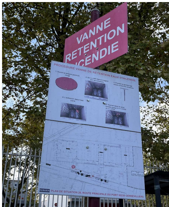
Annexe 11: Panneau d'affichage au droit d'une des vannes de rétention des eaux d'extinction présentant les modalités de mise en œuvre du dispositif d'isolement
