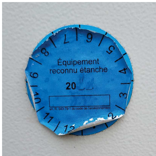
Figure 1: Marque de contrôle d'étanchéité non mise-à-jour (cf point de contrôle "Marque de contrôle d'étanchéité ")
