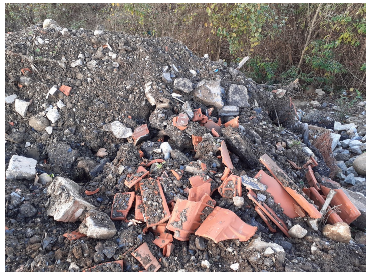
Photo 4 : dépôts de déchets inertes (tuiles, bétons et gravats)
