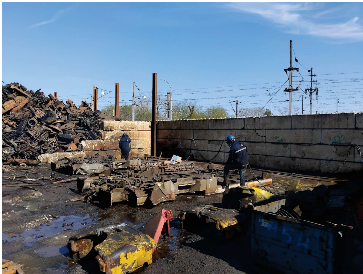
Découpe au chalumeau des châssis de wagons
