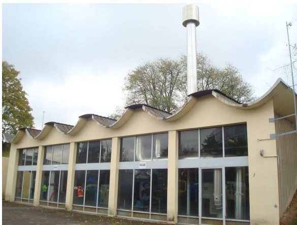
Figure 1: Extérieur de la chaufferie C
