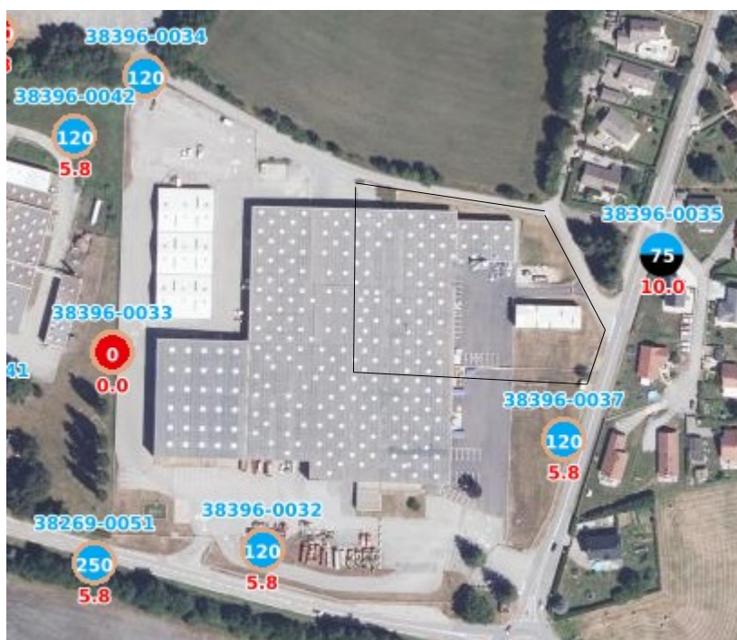
Implantation des poteaux incendie à proximité du site ROSI Alpes (données issues du SDIS)
