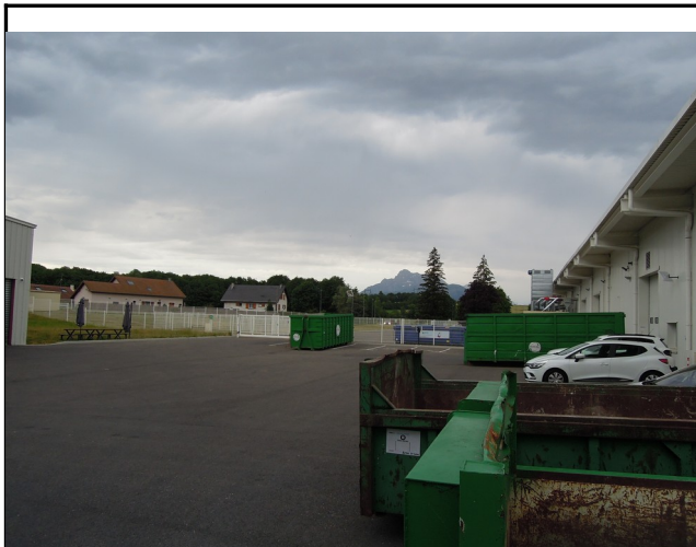
Bennes de déchets entreposées en pied de façade
