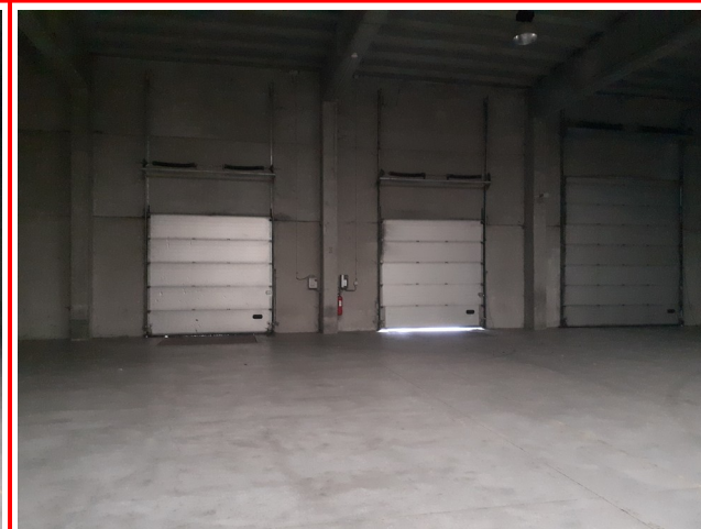
Entrepôt : vue vers les quais
