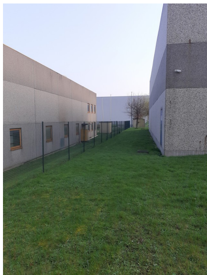
Extérieur : vue côté
