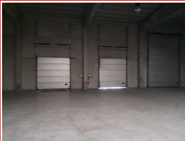
Entrepôt : vue vers les quais
