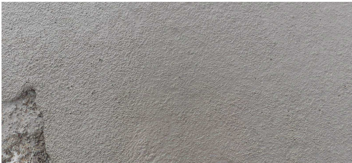
billes de polystyrène dans le béton frais
