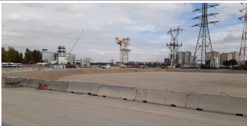
Zone où étaient implantés le bâtiment des filtres-presses
