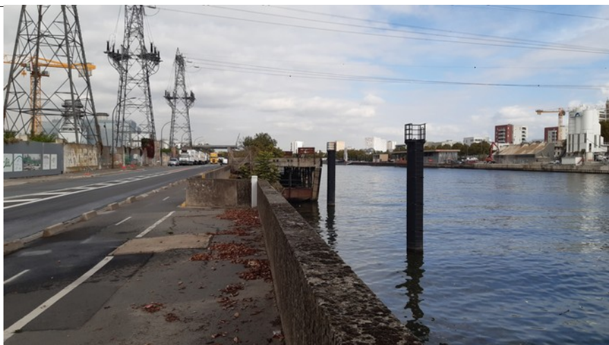
Ducs d'Albe laissés en place
