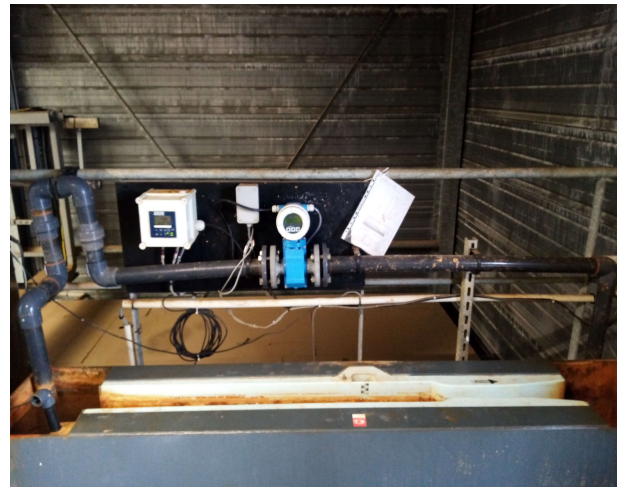
Illustration n°4: chaîne de mesures à la STEP Fonderie (débitmètre électromagnétique, canal venturi, etc.)
