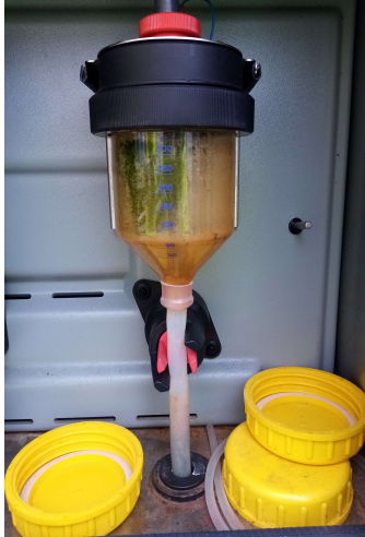
Illustration n°1: encrassement du bol préleveur et tuyauterie à la STEP Méca Illustration n°2: corrosion du trop-plein à la STEP Méca
