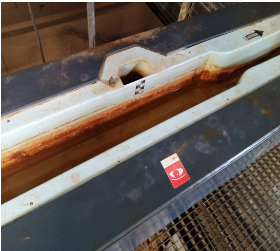
Illustration n°3: encrassement du canal venturi à la STEP Fonderie
