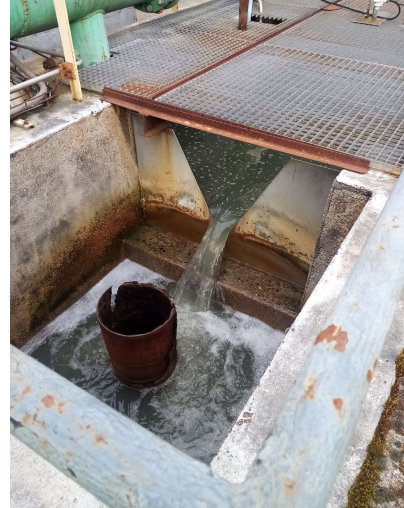
Illustration n°1: encrassement du bol préleveur et tuyauterie à la STEP Méca Illustration n°2: corrosion du trop-plein à la STEP Méca
