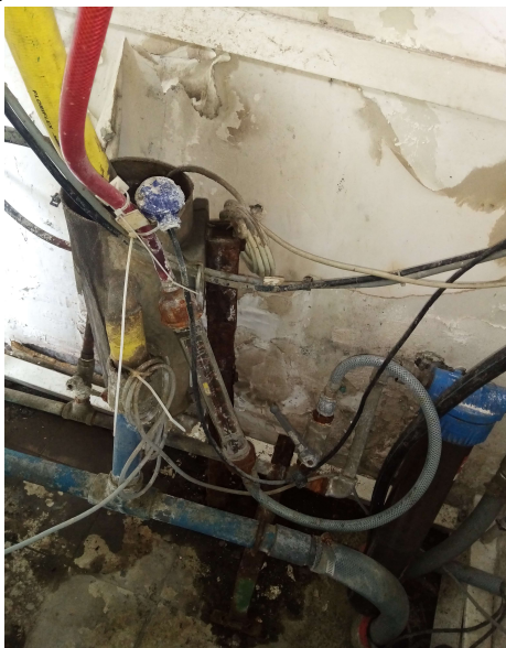
Illustration n°5: encrassement au point de prélèvement "Ovoïde"
