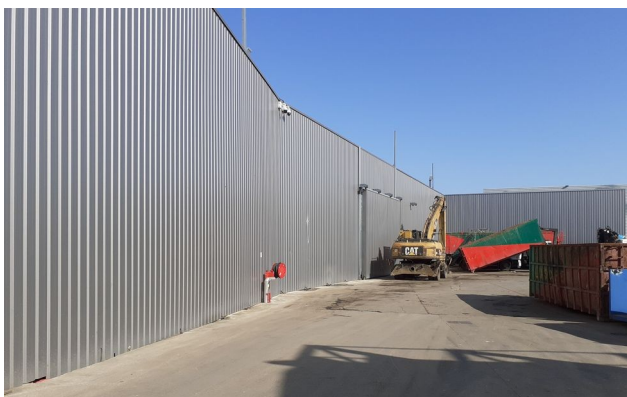
Mur installé depuis mai 2022
