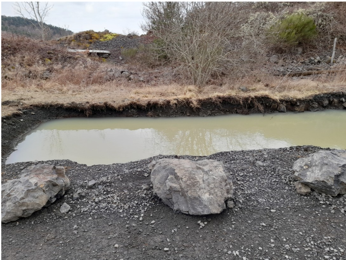
Réserve Incendie et Structure modulaire
