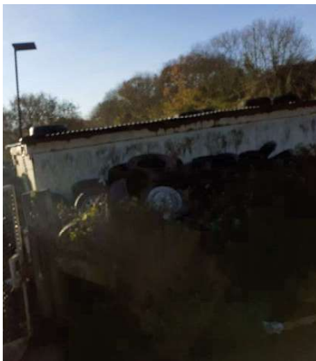
Dépot sauvage entre la clôture et le bâtiment
