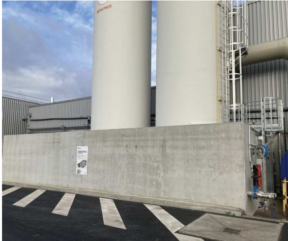
Cuves de stockage de la soupe - sur rétention
