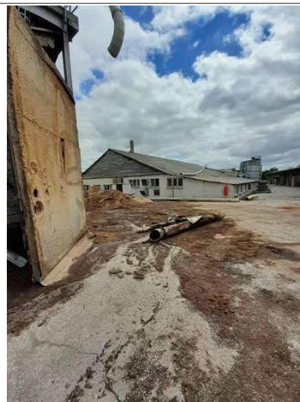
Copeaux de bois étalés au sol pour éteindre l'incendie
