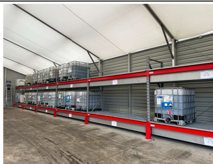
Photo n°8 : Stockage des GRV d'acides/bases
