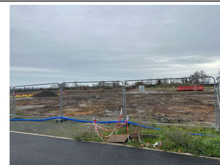
Photo n°9 : Travaux de terrassement en cours pour la future rétention R7
