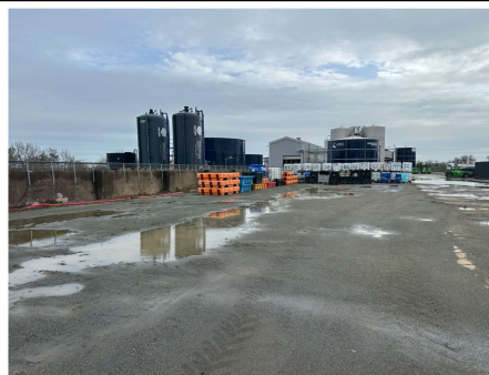
Photo n°5 : Stockage de GRV vides suite démantèlement des serres A et B
