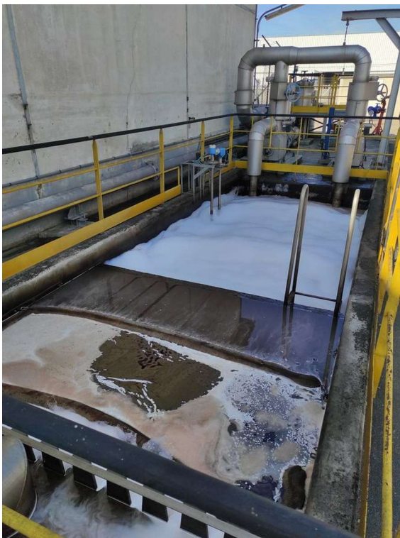
Illustration 9: Vu de la fosse et des deux pompes de relevage
