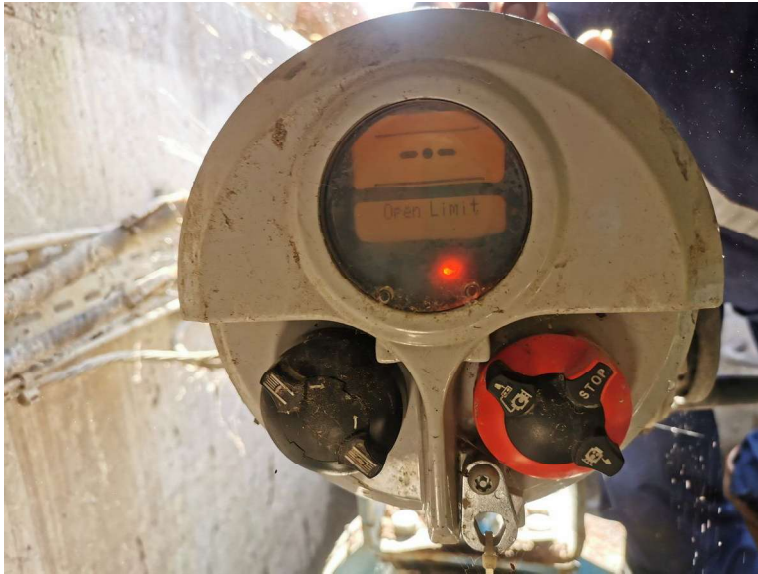
Illustration 11: Module de commande de la vanne de confinement
