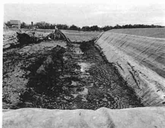
lagune en cours de vidange
