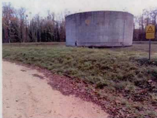
Voie stabilisée pour atteindre le BAC D4
