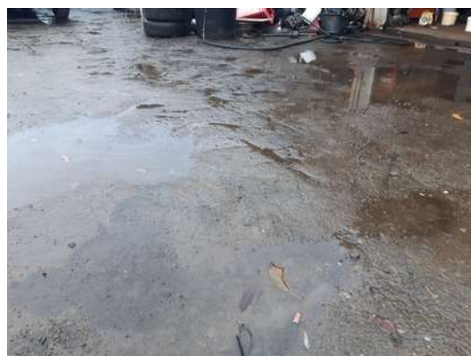
Pollutions engendrées sur un sol non imperméabilisé
