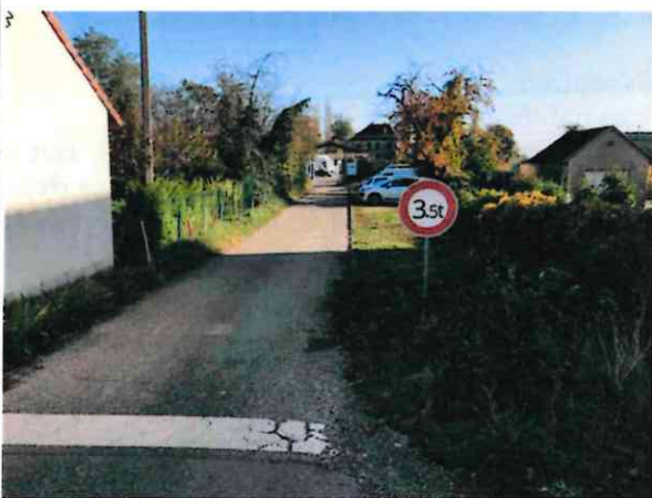
Figure 3: chemin d'accès connexe à la rue Sainte-Odile comportant un panneau d'interdiction aux véhicules de plus de 3,5 tonnes
