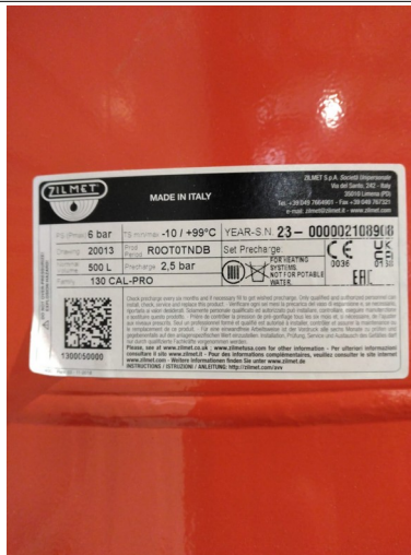
Plaque signalétique vase expansion n°série 23-000002108908 année 2013 PS= 6 bar V= 500 litres PS*V = 3 000
