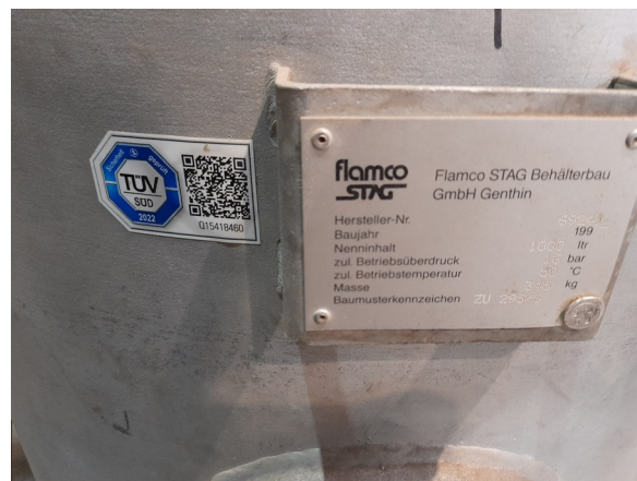
Plaque signalétique cuve compresseur Flamco n° série 6924 année 1997 PS= 16 bar ,V= 1000 litres PS*V= 16 000
