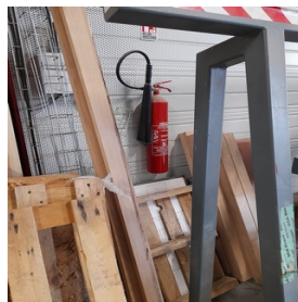
Exemple d'un extincteur difficilement accessible sur le site AtticorA
