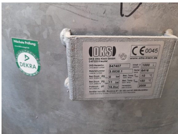
Plaque signalétique cuve compresseur OKS n°série 547407 année 2009 PS= 11 bar , V= 1000 litres PS*V= 11 000
