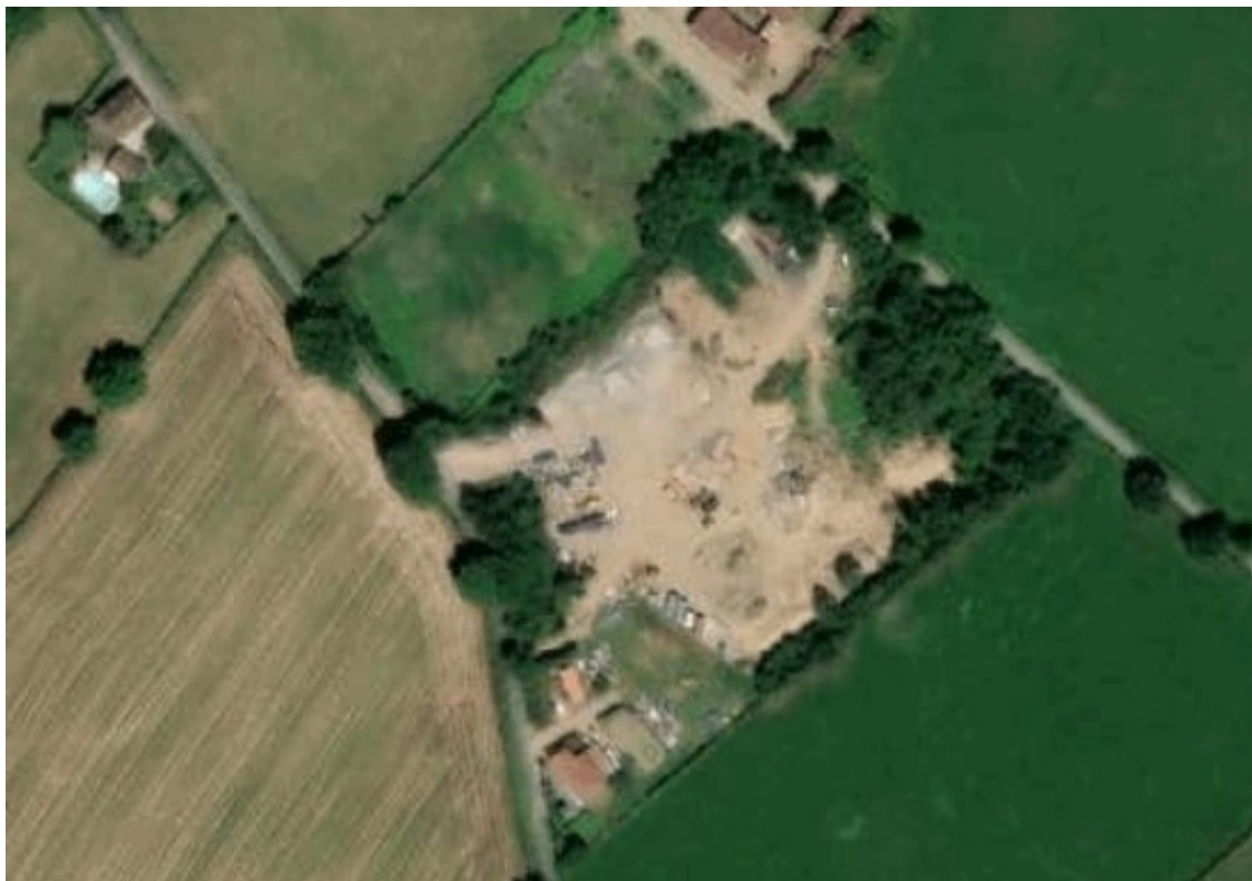
Figure 5: Vue postérieure à 2023 représentative de l'état actuel en regard du volume des remblais enfouis - Source : les pages jaunes
