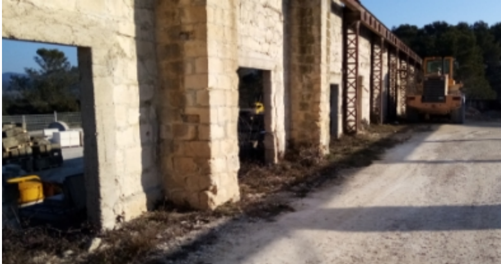
passages subsistant entre la carrière et l'habitation du tailleur de pierre au nord du site
