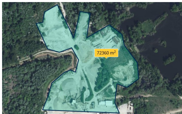
Surface de tri-transit + traitement où transitent les matériaux + atelier
