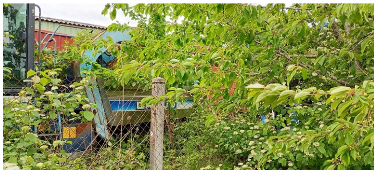
Cliché n° 17 : Vue derrière le bâtiment. Des machines sont encore dans la végétation.
