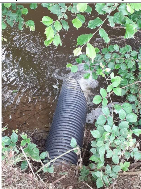
Point de rejet dans le milieu
