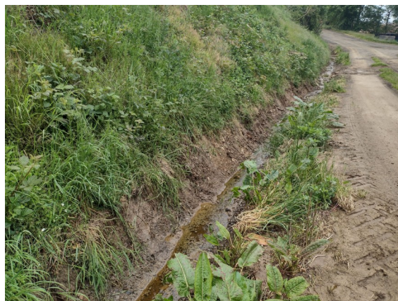
Photo 6 Fossé écoulement clair en contrebas fosse supérieure
