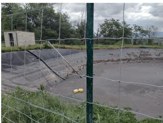
Photo 7 Fosse géomembrane inférieure
