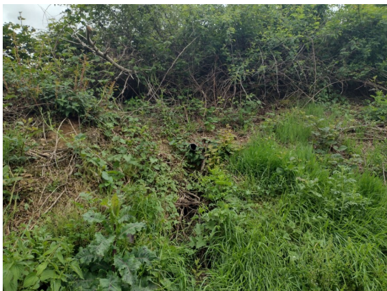
Photo 5 Exutoire drain sous fosse supérieure
