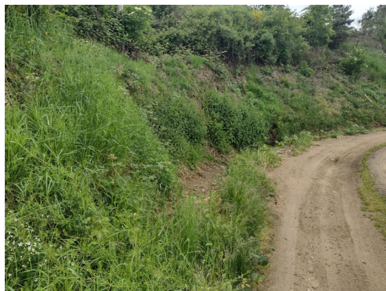
Photo 4 Fossé sous fosse supérieure
