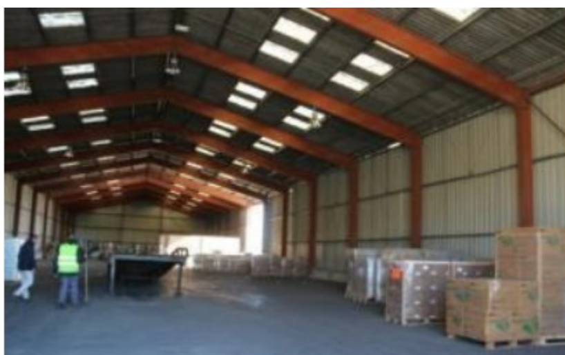
Vue intérieure du hangar
