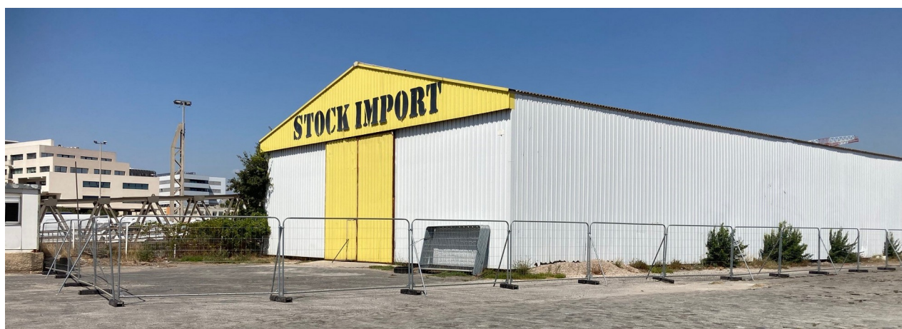
Vue extérieure du hangar
