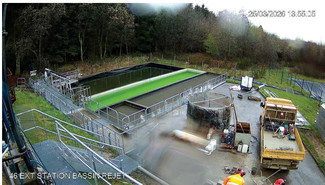
Bassin tampon après vidange (photo de l'exploitant prise le jour de la visite)
