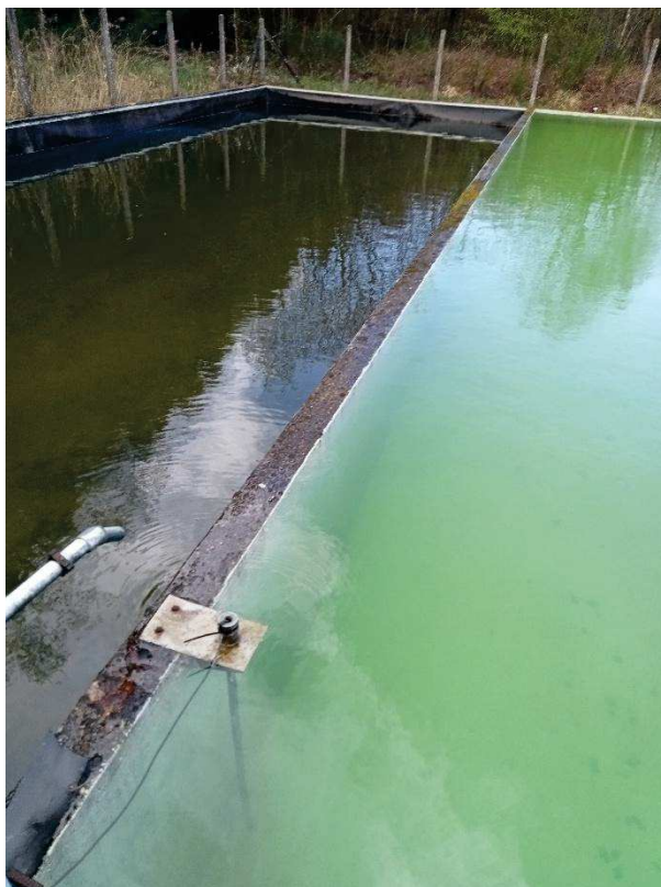
Bassin tampon commençant à déborder dans le bassin adjacent, lors de la visite d'inspection
