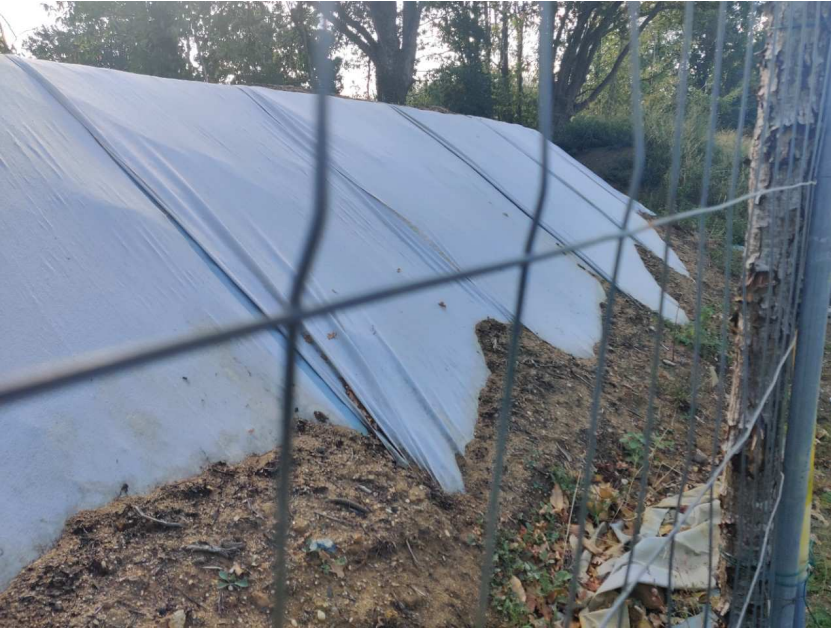
Merlon de terres polluées confinées
