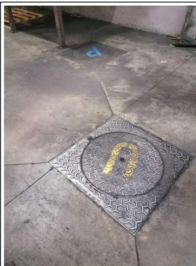
Figure 3: identification regards dans le hangar (eaux Pluviales et Usées)
